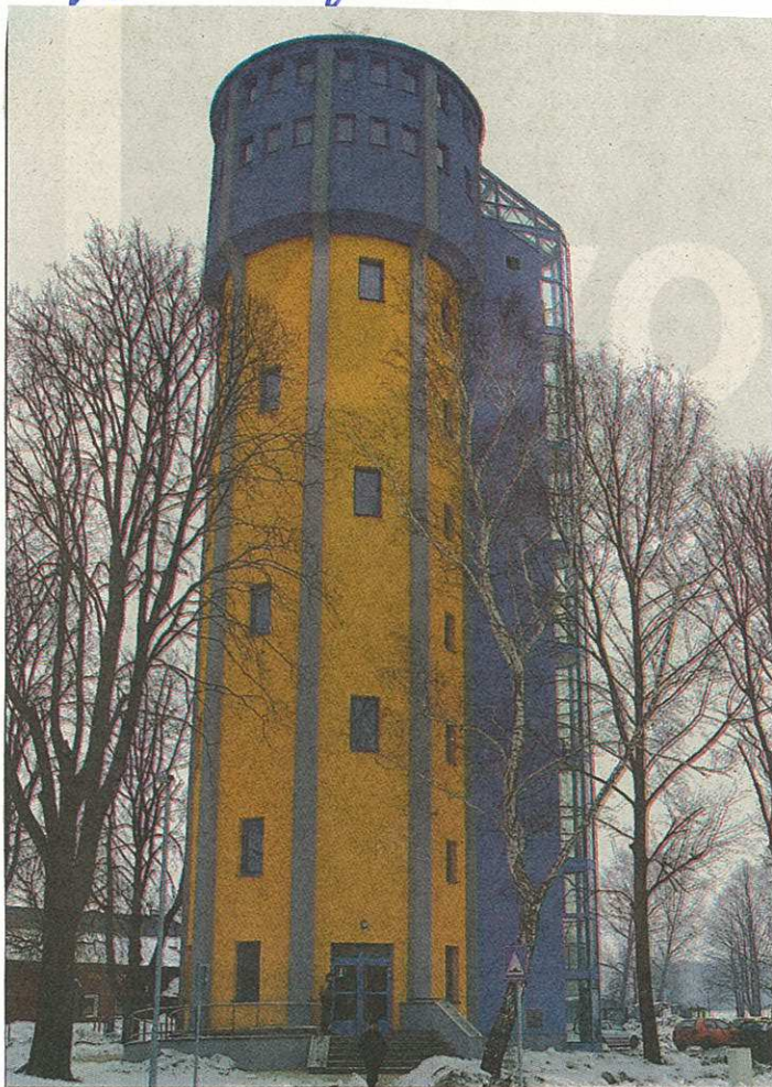
V BOHUMÍNĚ OTEVŘELI PENZIÓŇ VE VĚŽI. Unikátní projekt realizovali v Bohumíně. Otevřeli penzionek s vyhlídkovou restaurací, který vznikl přestavěním bývalé zchátralé čtyřicetimetřové vodárenské věže. Lidé se nyní mohou ubytovat v jednom ze 12 pokojů. (kij)
