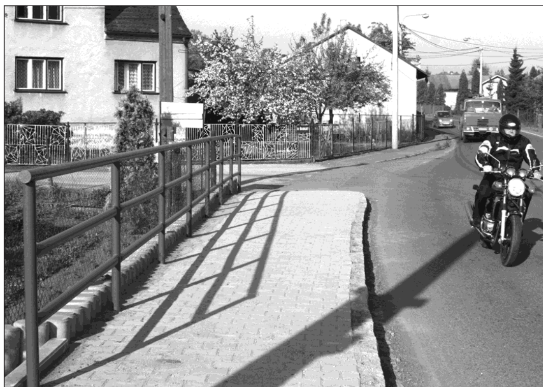
▲ Čtyřicet metrů nového chodníku vzniklo na mostě u nového Domu pro seniory ve Vrbici. Výstavba nového chodníku stála městský rozpočet 400 tisíc korun kvůli nutnému vybudování opěrné betonové zdi s výztuží.
