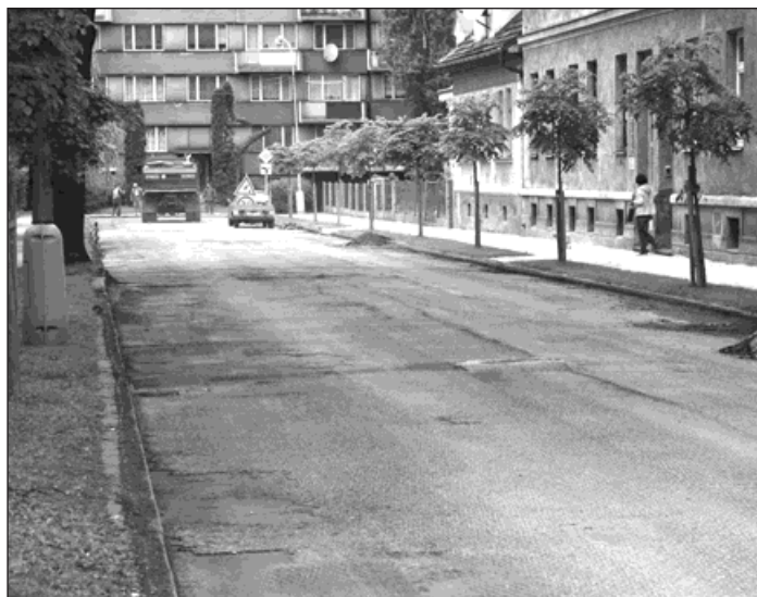
▲ Na opravy komunikací ve městě je pro letošní rok navýšen rozpočet o 5,2 milionů korun. Celkem letos město vloží do oprav chodníků a komunikací 13,2 milionů korun. Náš snímek byl pořízen těsně po vyfrézování vozovky na Masarykově ulici. Foto: František Krejzek
