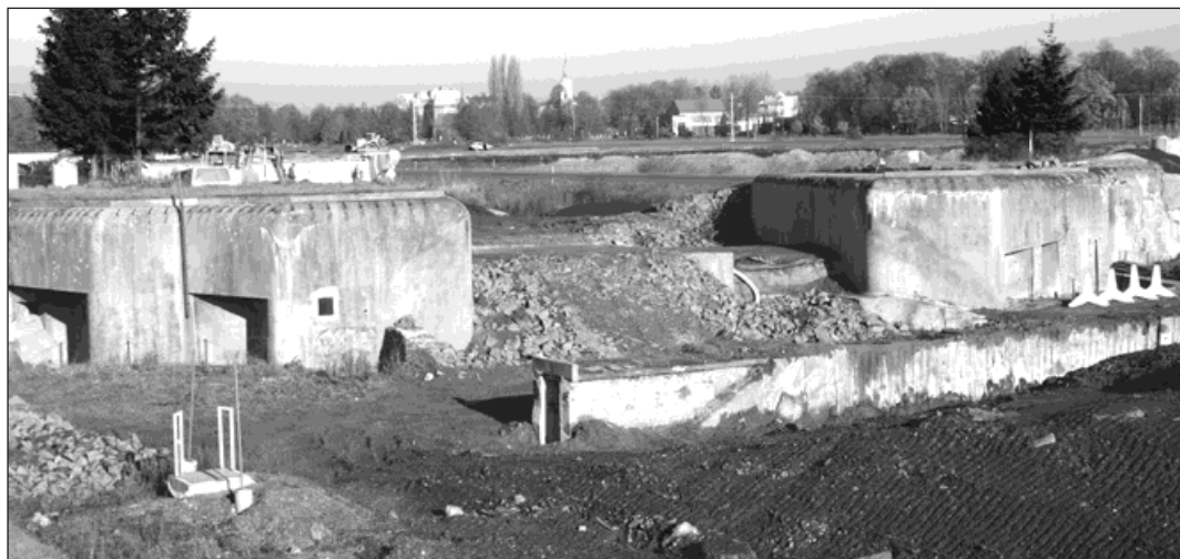
▲ V blízké budoucnosti bude spojovací chodba mezi oběma částmi bunkru opět zasypána zeminou a povede nad ní silniční doprava. Foto: František Krejzek
