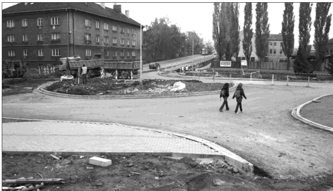
▲ I přes zhruba měsíční zpoždění se již kruhový objezd rýsuje. Průjezdu touto křižovatkou se však, pokud můžete, raději vyhněte. Foto: František Krejzek
