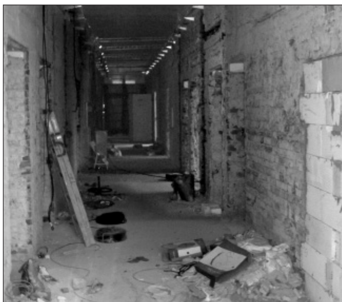
Interní oddělení prochází rozsáhlou rekonstrukcí, při které nezůstane doslova kámen na kameni.
