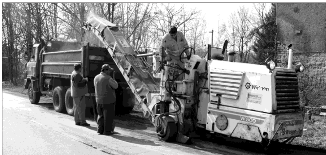
Na Drátovenské ulici frézují výtluky po zimě a připravují je k opravám.
