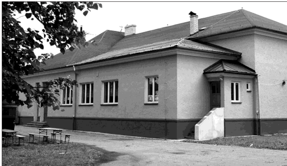
Na odstranění havárie na střeše sokolovny v Záblatí a na dokončení sociálního zázemí město věnovalo sokolům 70 tisíc korun. foto: Archiv redakce
