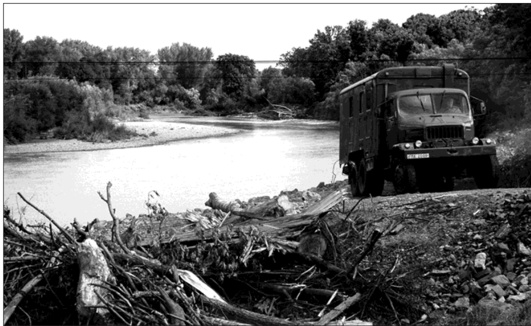
Zabezpečovací práce v meandrech skončily 28. července. Opravený břeh se po čase dočká i nové zeleně.
