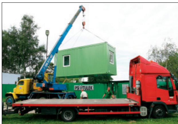
Těžká technika instalovala v útulku novou správní buňku. Její pořízení včetně dopravy a zapojení rozvodů přišlo na čtvrt milionu
