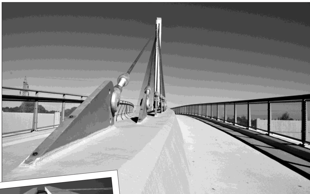
Dálnice radikálně změnila podobu Ostravské ulice ve Starém Bohumíně. Místo klasické silnice zde vyrostla lávka pouze pro pěší a cyklisty. ◀ Centrální pylon, ze kterého je nataženo čtyřiačtyřicet ocelových lan. Foto: Pavel Čempěl
