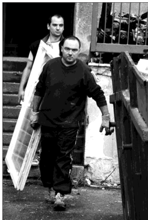
Poslední okna v letošním roce se měnila od 24. do 27. října ve dvou věžích v Alešově ulici.
