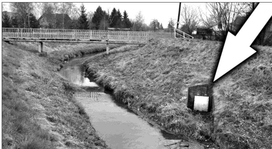
Práce začnou u Bohumínské stružky, kde ústí bezejmenný potok v potrubí. Nyní z něj ale voda odtéká špatně nebo vůbec. Foto: Pavel Čempěl
