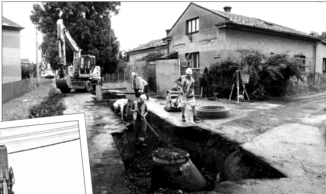
Kvůli budování kanalizace musely být už tak úzké uličky pro dopravu uzavřeny. Ve většině ulic probíhají klasické výkopové práce. Foto: Pavel Čempěl
