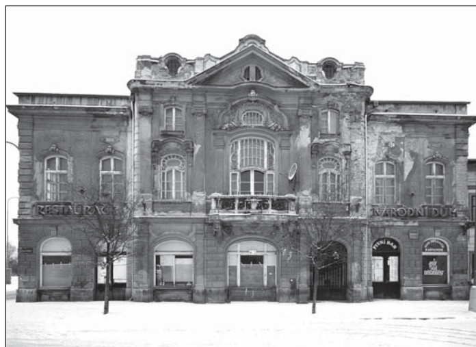
Projektová dokumentace oprav už existuje, ale musela by se aktualizovat. Od jejího vzniku se ledacos změnilo, například už je kompletně opravená střecha. Foto: Pavel Čempěl
