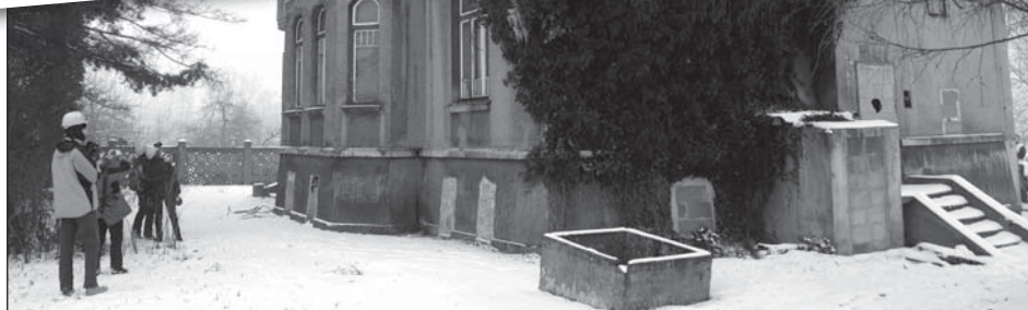
Přestože už je na vilu vydán demoliční výměr, během probíhajícího řízení o prohlášení za kulturní památku ji majitel zbourat nemůže. Ve vile prý hrozí nebezpečí úrazu. Bez ochranné přilby dovnitř nikdo nesmí. Foto: Pavel Čempěl
