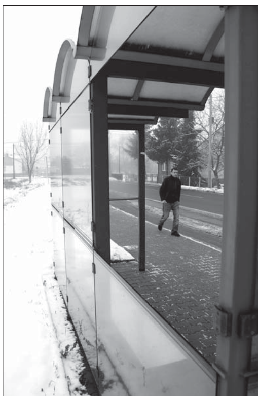
Přístřešku v Ostravské ulici chybí dvě skleněné tabule. Zejména v zimě, kdy z polí vane severák, tady není čekání nic příjemného.
