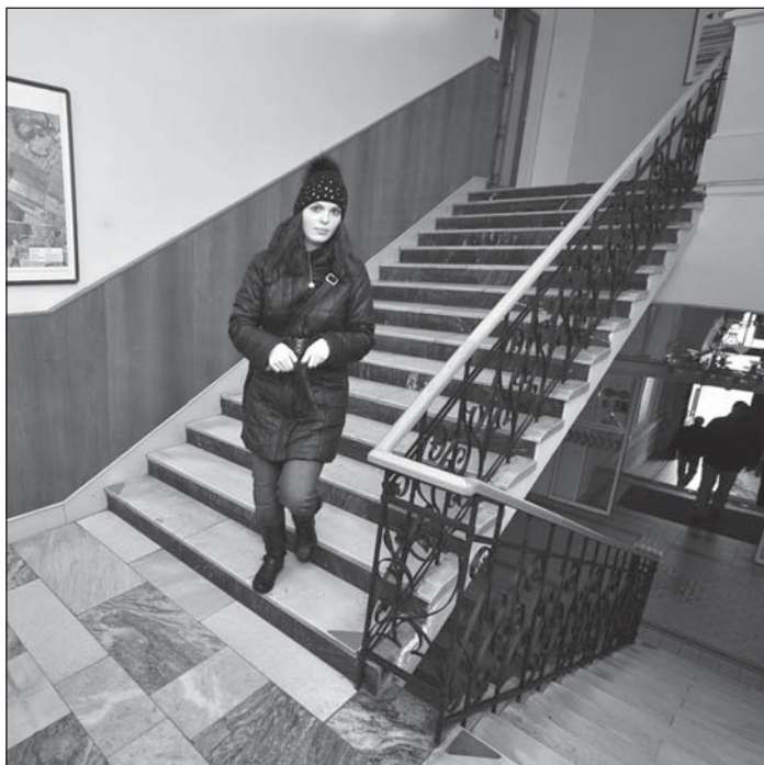
Uprostřed schodiště už je (staro)nové zábradlí. Nyní se budou opravovat boční zdi, z nichž mizí dřevěné obložení.
