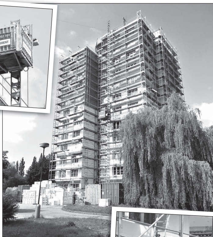
V Bezručově ulici se rekonstruuji dva sousední věžáky, číslo 1143 (na snímku nahoře) a 1145. Věžové domy se především zateplují. Jejich okna už byla vyměněna před čtyřmi lety.
