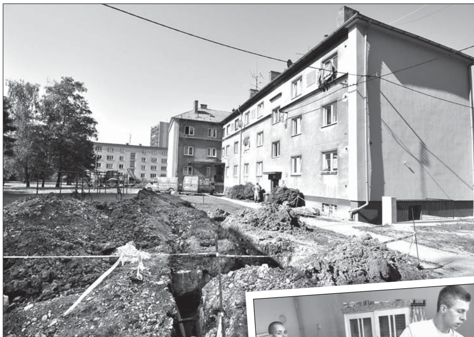
Domy v Nerudově ulici poblíž hřbitova se napojují na centrální zásobování teplem (CZT). Gamata jsou minulostí. Do bytů se instaluje ústřední topení. Foto: Pavel Čempěl
