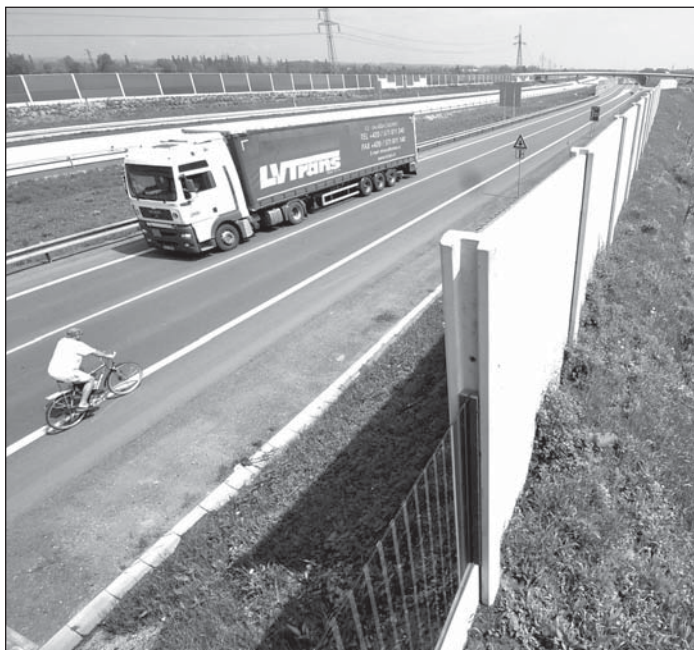
Na hluk z dálnice se při jejím projektování myslelo a stavěly se protihlukové stěny. Podle některých obyvatel jsou ale málo účinné.
