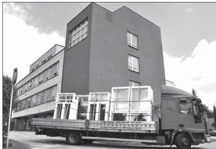
Stavbaři přivážejí nová okna k poliklinice. Vzhled střediska se změní nejen díky nim, jiná bude i barva fasády. Podle projektu půjde o kombinaci pískové a azurové. Foto: Pavel Čempěl
