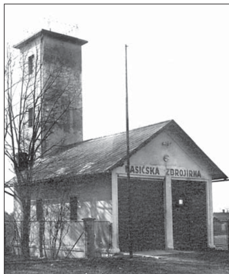
V roce 1934 byla dána do užívání budova obcí propůjčené hasičské zbrojírny.
