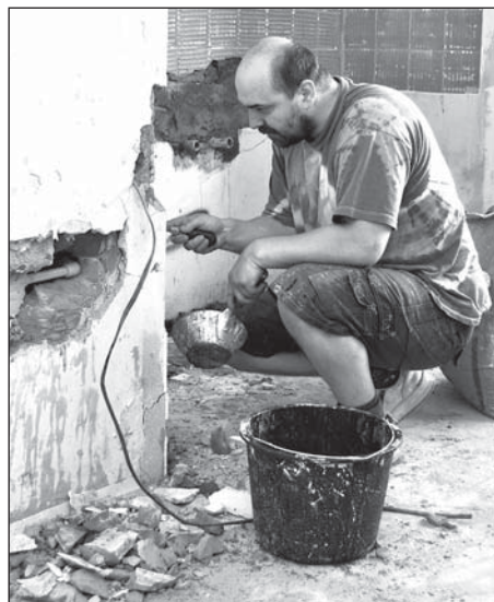
V Janáčkově ulici za parkem je přestavba bytů radikální. Lidé tady budou mít nové koupelny i kuchyně.
