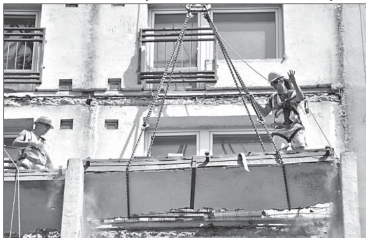
Práce na domech v Nerudově ulici probíhají současně, každý ale rekonstruuje jiná firma. Nejsložitější operací je demontáž lodžií. Foto: Pavel Čempěl
