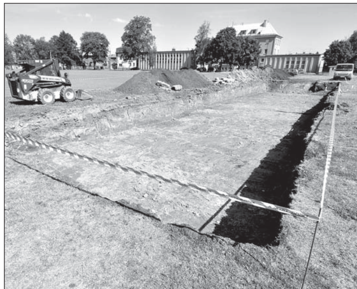
Uprostřed fotbalového areálu mezi dvojicí hřišť vznikají základy budoucí tribuny. Foto: Pavel Čempěl
