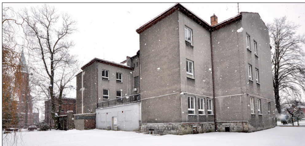
▲ Stavby z červených neomítaných cihel byly na počátku minulého století v kurzu. Ovšem budova po necitlivých úpravách a nahození brizolitové omítky o původní vzhled přišla. Nemluvě o nešťastné přístavěných šatnách. Objekt sloužil desetiletí učňovskému školství. Nyní jej bude třeba upravit potřebám nových uživatelů.
