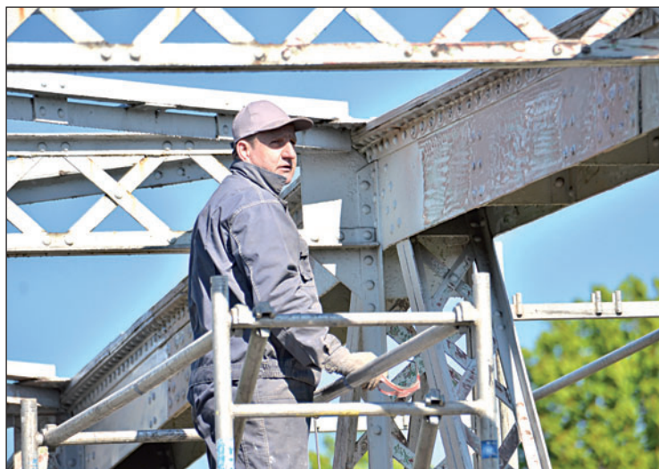
Hraniční most obepíná na straně Chałupek lešení. Pracovníci odstraňují staré nátěry ocelové konstrukce a opatří je novými.
