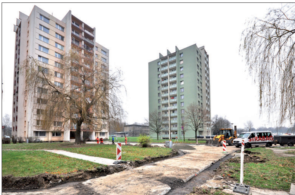
Práce u trojice věžáků v Bezručově ulici pokračují. Cestáři odstranili starou popraskanou živici a budou pokládat nový koberec na komunikacích a nástupních plochách. Foto: Pavel Čempěl
