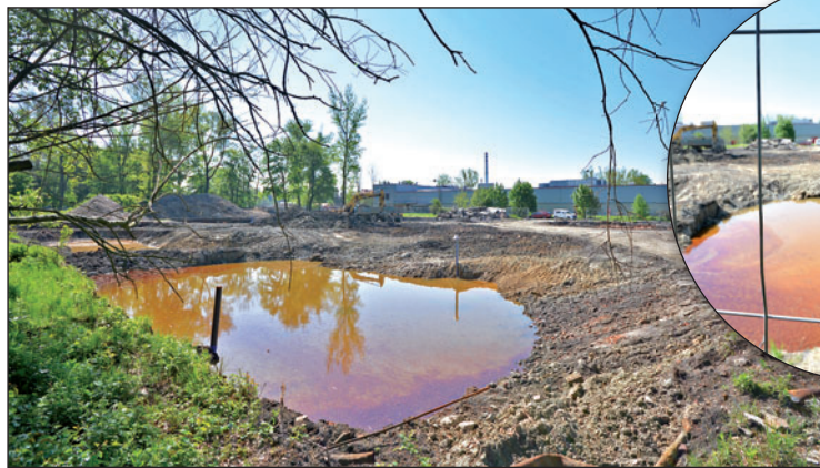
Firma odtězuje zamořenou zeminu až do hloubky pěti metrů. Olejové skvrny na hladině spodní vody dokazují, jak silně je lokalita znečištěná.
