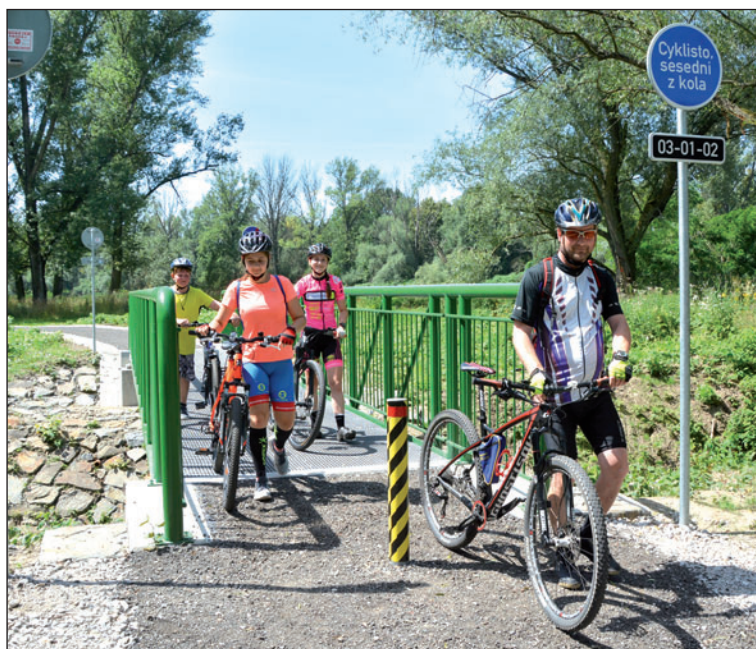
▲ Ocelová lávka nad vrbickou Stružkou už slouží. Je ukotvena na osmimetrových pilotách, takže by měla ustát i případné silné povodně.
