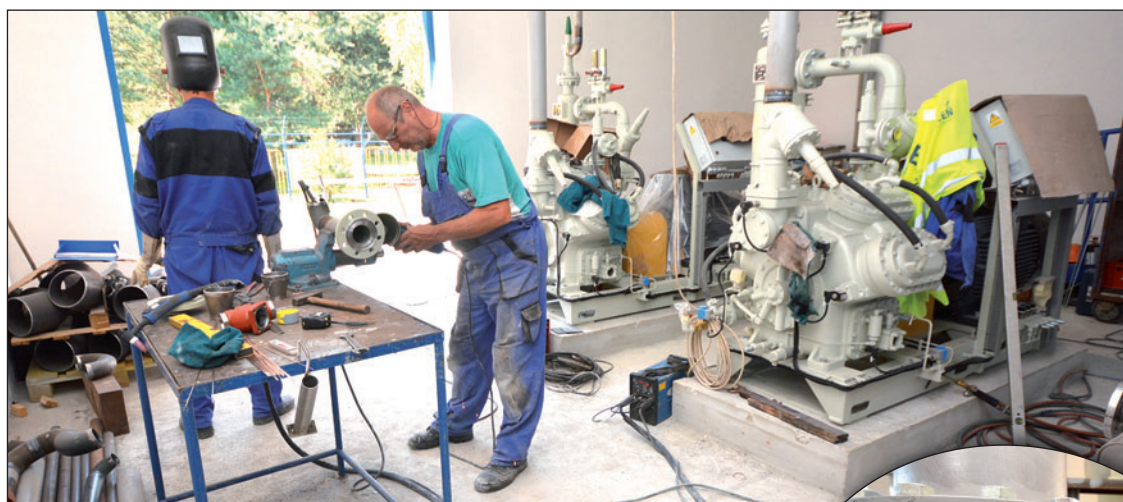
Specializovaná firma dokončuje technologii chlazení zimáku, které je nesrovnatelně menší než původní. V srpnu bude probíhat jeho testování. Foto: Pavel Čempěl
