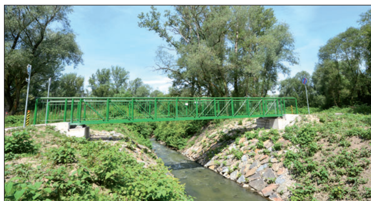
▲ Ocelová lávka nad vrbickou Stružkou už slouží. Je ukotvena na osmimetrových pilotách, takže by měla ustát i případné silné povodně.
