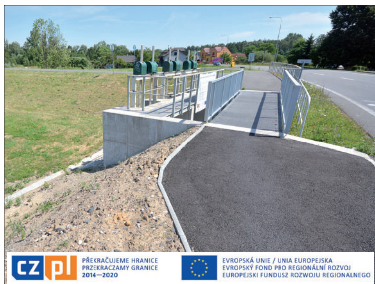
Cyklisté a jezdci na bruslích se bezpečně dostanou z parkoviště na stezku díky novému chodníku a lávce u vrbické protipovodňové hráze. Foto: Pavel Čempěl
