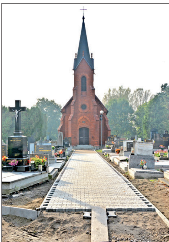
Výstavba nového chodníku na hřbitově ve Starém Bohumíně. Foto: Pavel Čempěl
