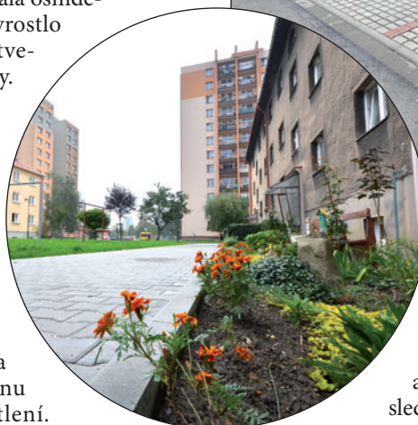
Nová parkoviště, chodníky, upravená zeleň. Vyprojektovaná obnova vnitrobloku po třech letech skončila.
