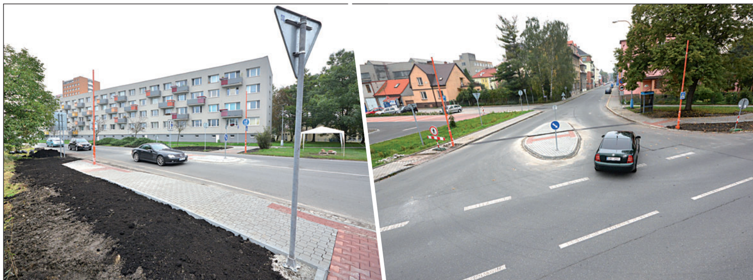
Součástí dvou nových přechodů jsou také ostrůvky uprostřed vozovky. V ulici Osvoboditelů se jej podařilo smysluplně zakomponovat do vozovky. Na velký ostrůvek u křižování ulic Jana Palacha a Studentské si budou muset řidiči chvíli zvykat (viz foto vpravo).
