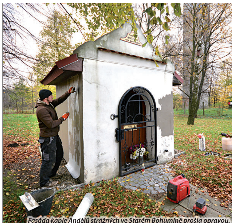
Fasáda kaple Andělů strážných ve Starém Bohumíně prošla opravou.
