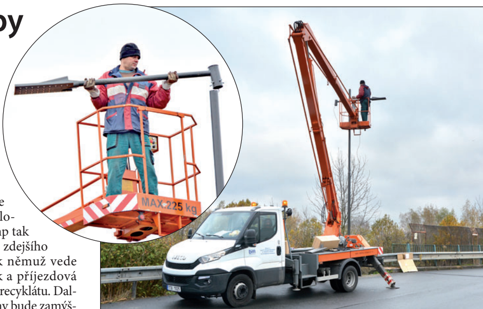
Na drátovenském mostě proběhla výměna osmi sloupů veřejného osvětlení.
