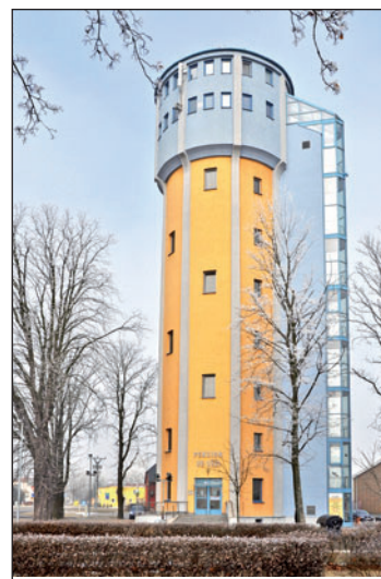
Penzion ve věži je architektonickým unikátem, který vznikl v roce 2005 přestavbou bývalého vodojemu. V »noze« jsou hotelové pokoje, nad nimi vyhlídka a nově otevřená kavárna.
