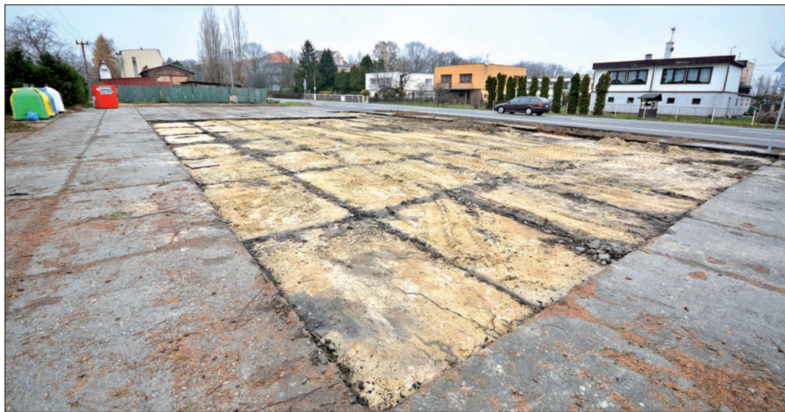
Smyslem úprav je rozdělit velkou, nevyužitou a nevzhlednou plochu zelení a dát jí kvalitní povrch. Část panelů už je pryč a na jejich místě proběhne výsadba a vznikne cyklodráha pro děti.
