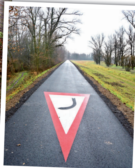
Původně šterková pěšina na valu dostala kvalitní asfaltový koberec. Nový úsek cyklostezky začíná napojením u lávky, která loni překlenula Orlovskou stružku.
