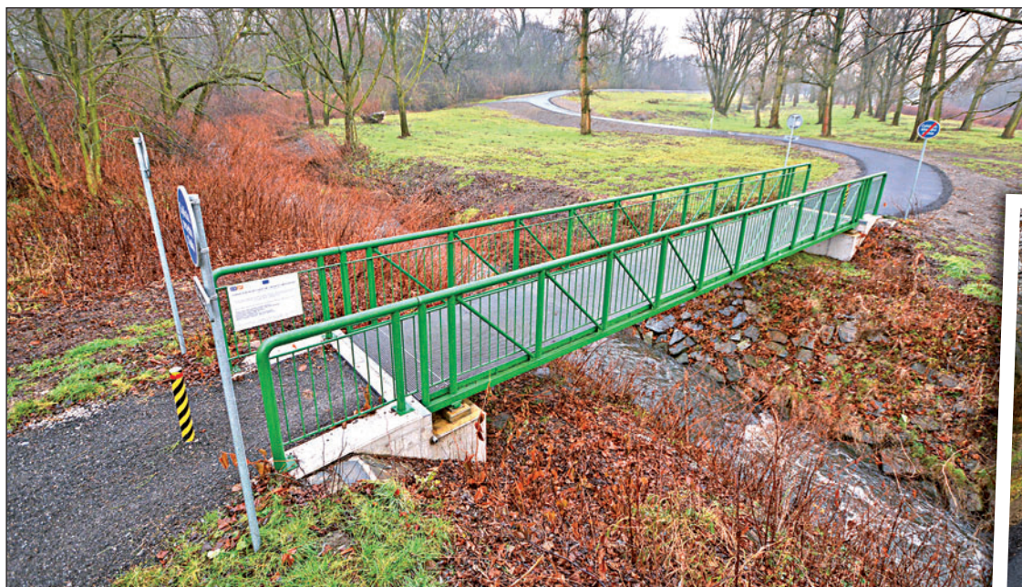
Původně šterková pěšina na valu dostala kvalitní asfaltový koberec. Nový úsek cyklostezky začíná napojením u lávky, která loni překlenula Orlovskou stružku.
