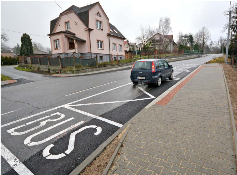
Nová zastávka Na Zálesí s refýží a přístupovým chodníkem.
