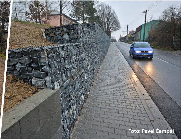
Svah poblíž záblatské školy zpevnila kamenná zeď.
