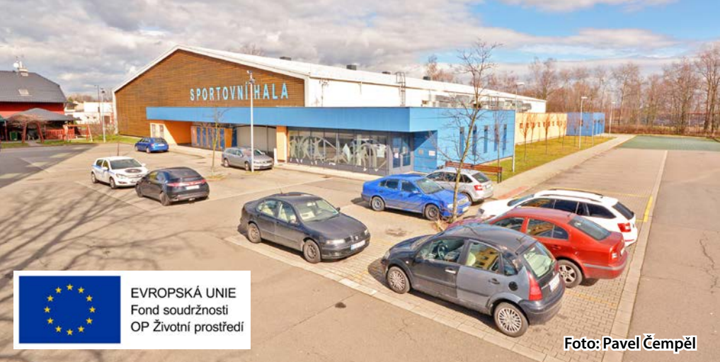
Bohumínská sportovní hala je díky rozměrům 62 x 44,5 metru a čtyřmi hřišti pod jednou střechou držitelkou rekordu. Nyní na ní vyroste také první městská fotovoltaická elektrárna.
