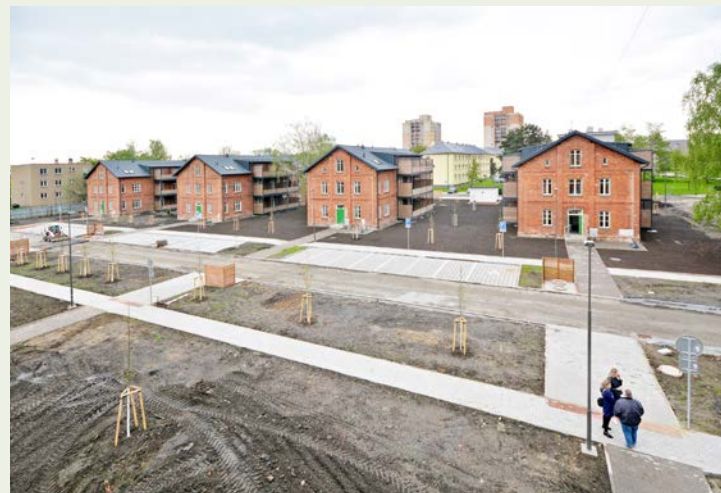
V plném proudu už jsou licitace bytů v kompletně zrekonstruovaných osmi domech v Červené kolonii.
