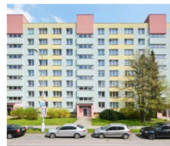
V centru v panelovém domě ve Štefánikově 1077 je k dispozici byt 2+1. Zájemci si jej mohou prohlédnout 3. a 4. července, licitace se koná 10. července.
