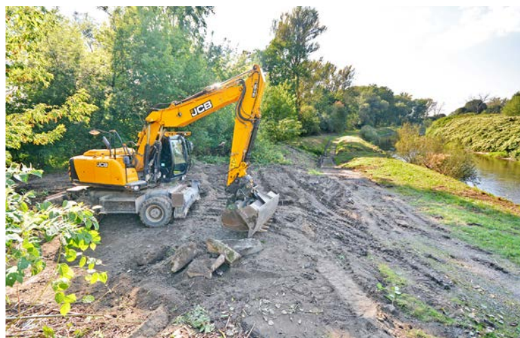
U Olše (Olzy) v blízkosti bývalého statku Červín začalo budování lávky přes Lutyňku, kde dosud sloužil brod.
