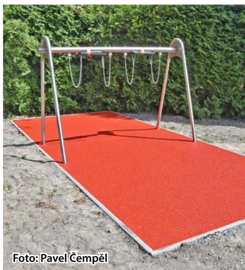
Plochy z lité pryže jsou vysoce elastické. Směs tvoří granulát s polyuretanovým pojivem.
