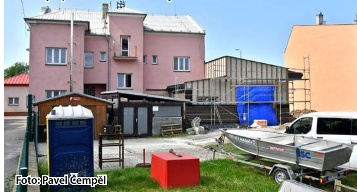
Probíhající přístavba hasičské zbrojnice ve Starém Bohumíně.
